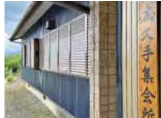
広久手町内会集会所 外壁工事
