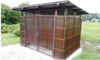
4、中切3組 ゴミ置場
