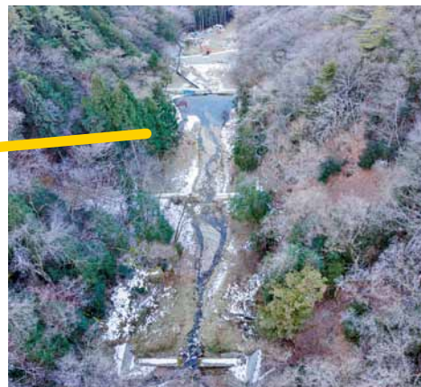
滝ヶ洞堰堤群
