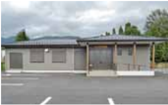
1-1 東諏訪クラブ新築
