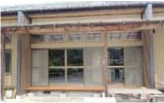
1-2 下洗井クラブ耐震補強
