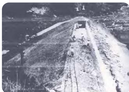
完成間近い源根溜池工事風景
