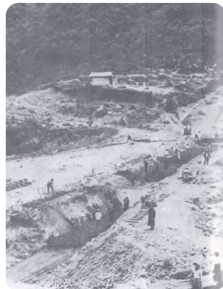
源根溜池工事風景
