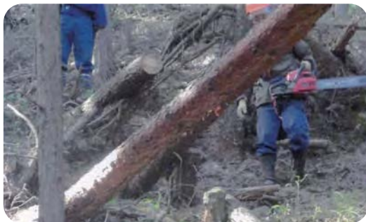
整備作業風景
