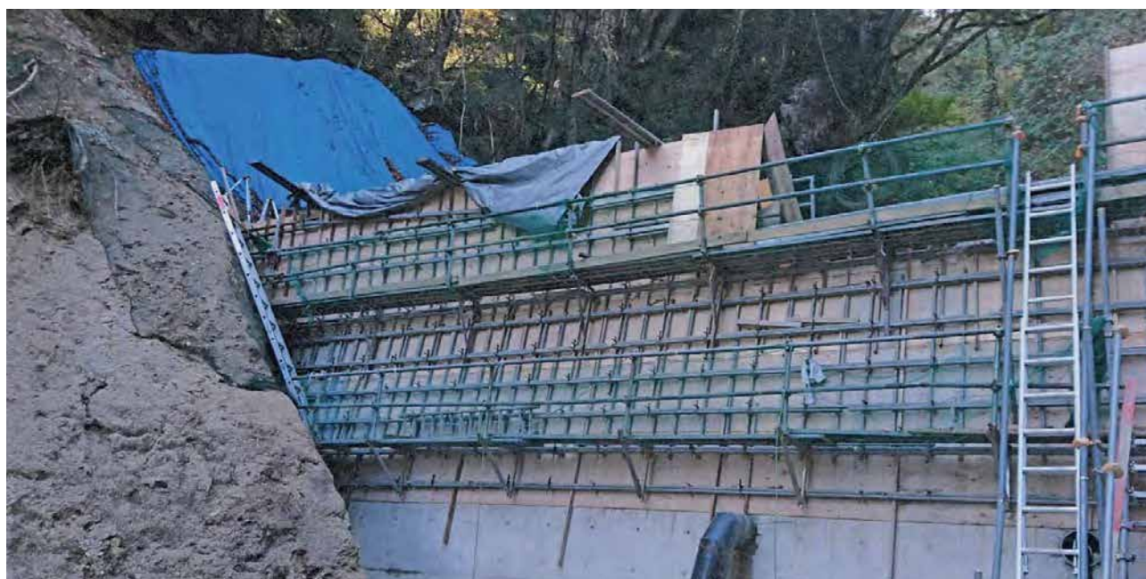
滝ヶ洞 治山堰堤工事
