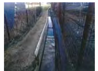
茄子川大池(三坂溜池)用水路補修工事
