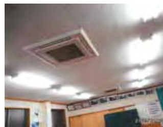
曙区 クラブ空調設備事業 (天井型エアコン)
